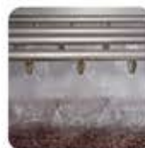
清浄な地下水による洗浄
